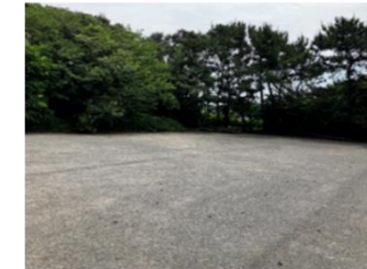
15m×20m アスファルト舗装
