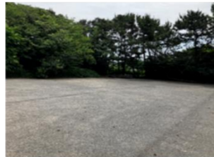
15m×20m アスファルト舗装
