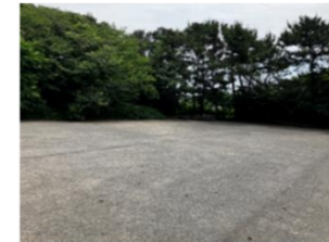
15m×20m アスファルト舗装
