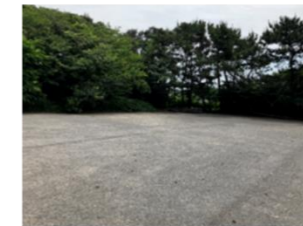
15m×20m アスファルト舗装
