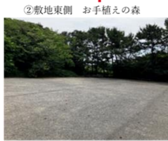
15m×20m アスファルト舗装
