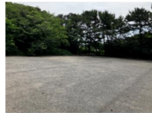
15m×20m アスファルト舗装
