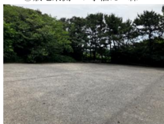
15m×20m アスファルト舗装
