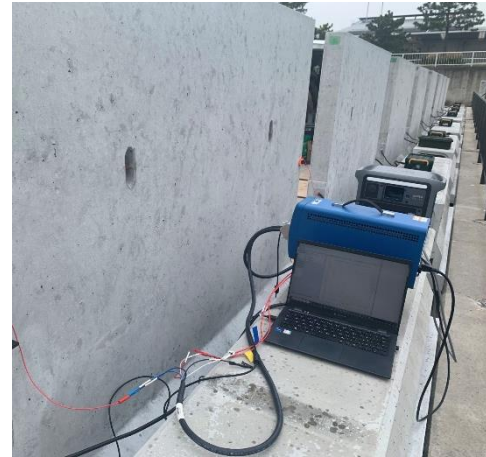
鉄筋腐食評価の様子
