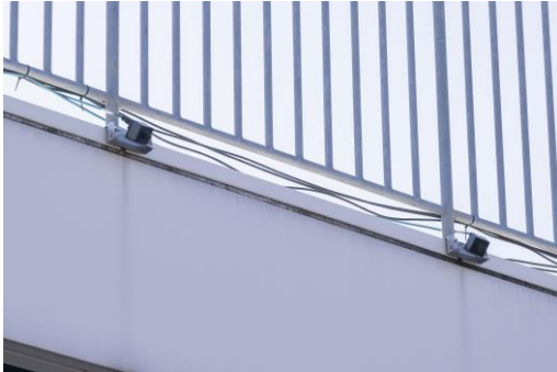
センサーカメラ (自律運行に必要な知能を インフラ側に設置)
