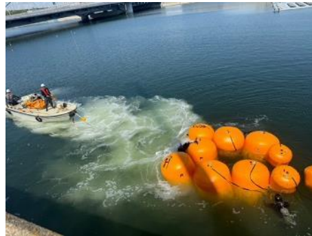
バルーンを使用した海底所定位置への設置
