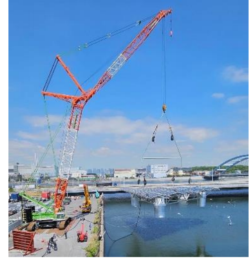
大型クレーンにより設備を吊り上げ設置
