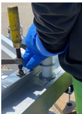
トラス部材のピン接続
