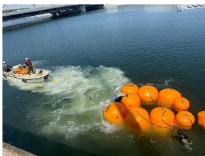
係留用重りとバルーンによる設備の係留
