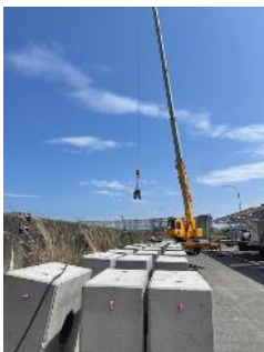
係留用重りとバルーンによる設備の係留
