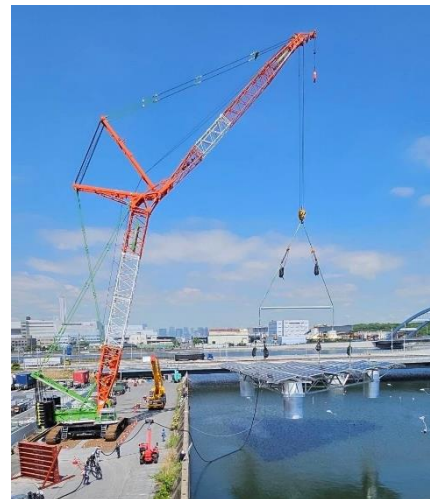
洋上浮体式太陽光発電設備 (2024年4月設置)
