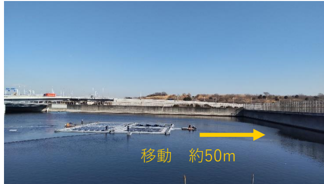
②作業台船（2台）による曳航・移動
