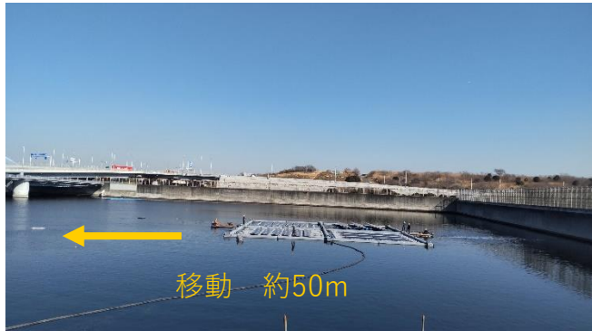
④作業台船（2台）による曳航・移動
