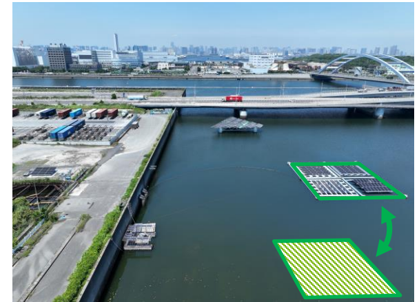
浮体の移動・復旧 約50m
