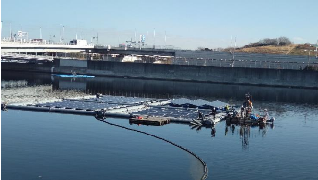
①係留チェーンの取り外し（8箇所）
