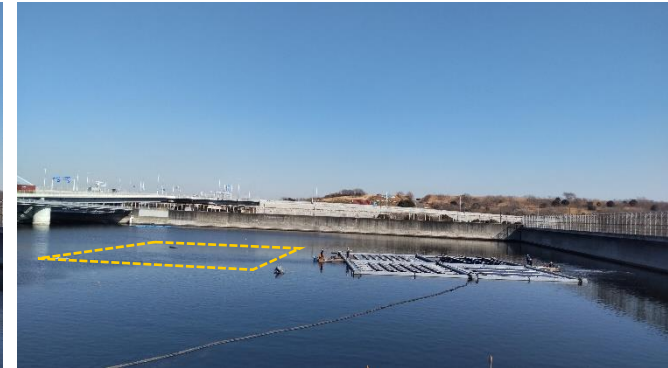
③移動完了（約50m）と仮係留（4箇所）
