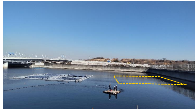
⑤係留チェーンの取付け・復旧完了（8箇所）
