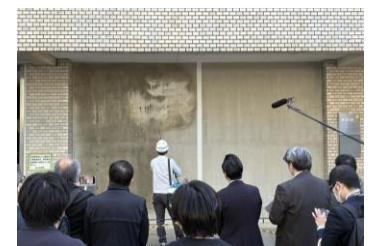
実建物への公開試験施工 @品川区役所庁舎
